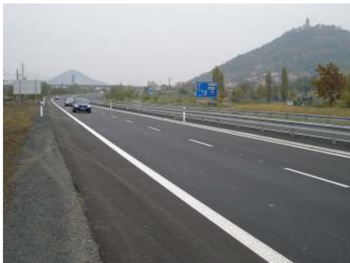
Silnice I 13 Komoňany - Most
