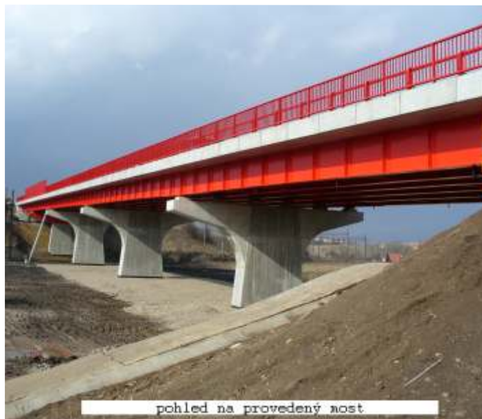
Silnice I 15 Most
