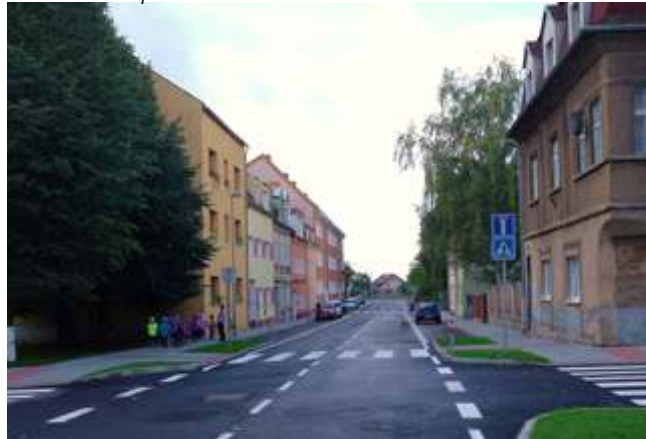
Školní ulice po rekonstrukci
